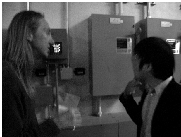
図 2: 電源設備の説明を行う Draney 氏
